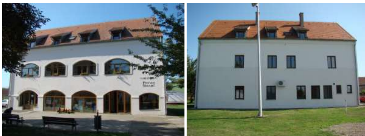
Slika 46. Zapadno i istočno pročelje zgrade galerije Petar Smajić
